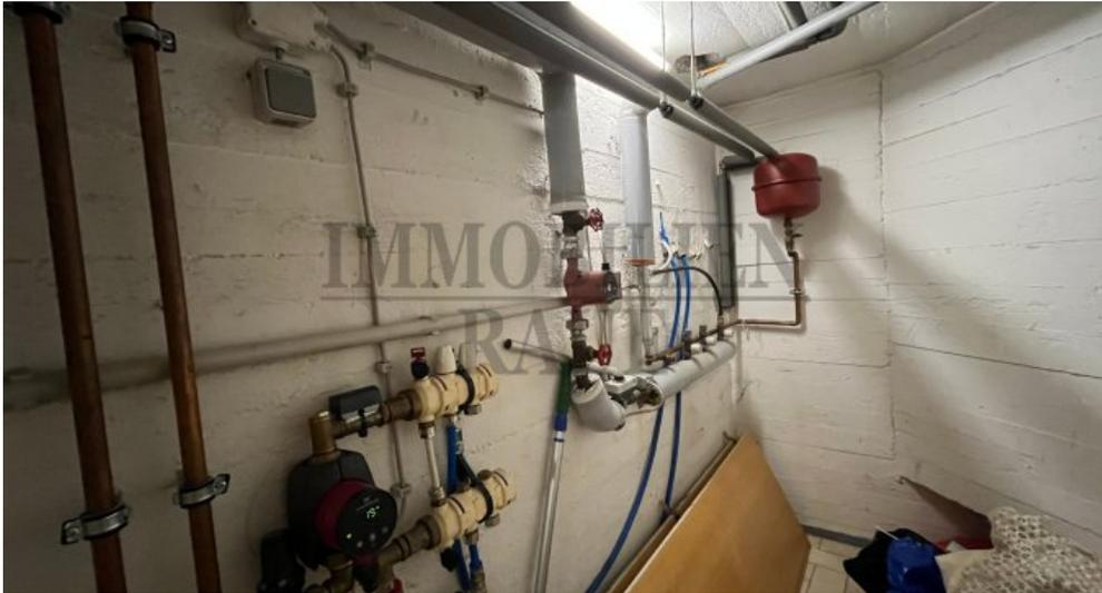
Steuerung Fußbodenheizung (Anbau)
