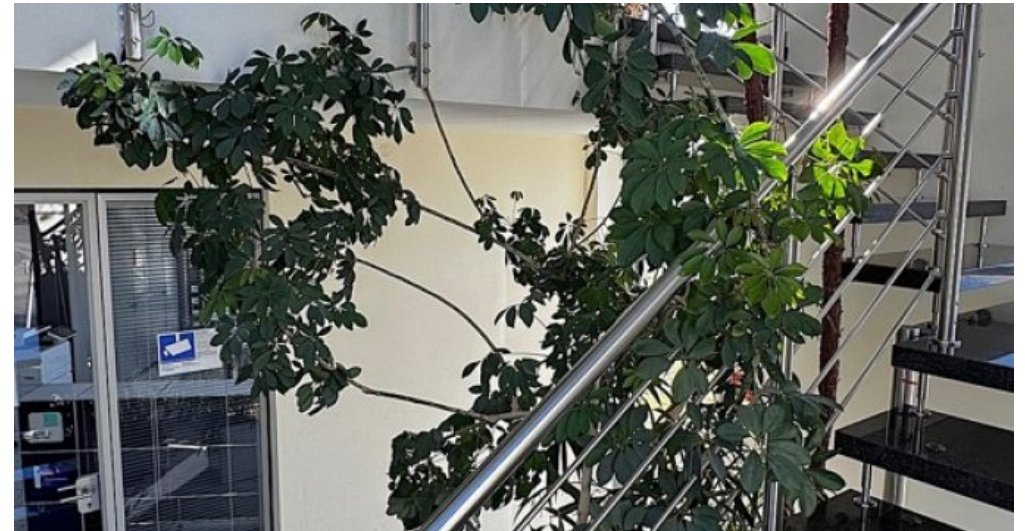
Treppe zum OG
