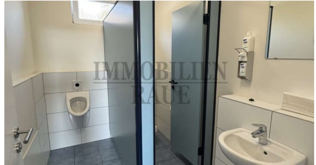
1. OG Herren WC-Anlage
