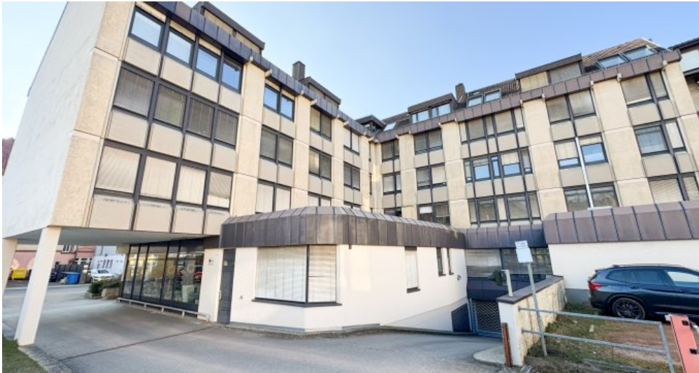
Rückansicht Gebäude/Tiefgaragen Einfahrt
