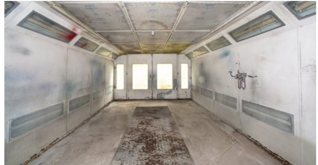
ehem. Lackierkabine 2. UG
