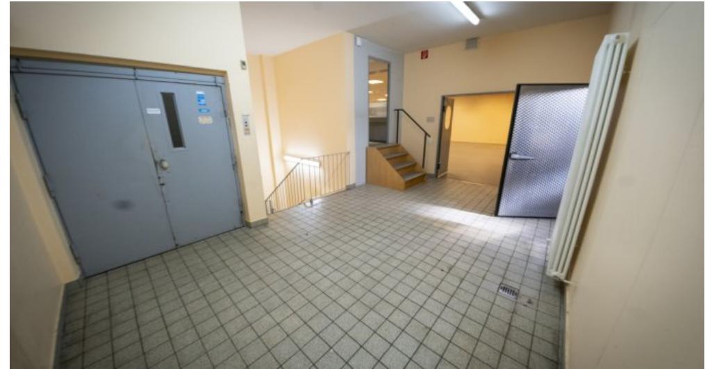
Lastenaufzug und Leitstand
