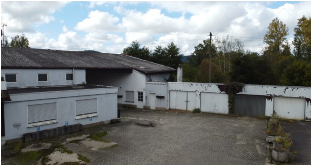
Anlageobjekt: Hallen, Wohnungen
