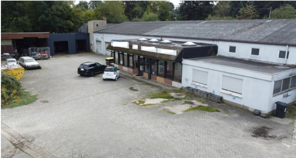
Anlageobjekt: Hallen, Wohnungen
