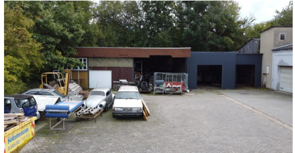
Anlageobjekt: Hallen, Wohnungen
