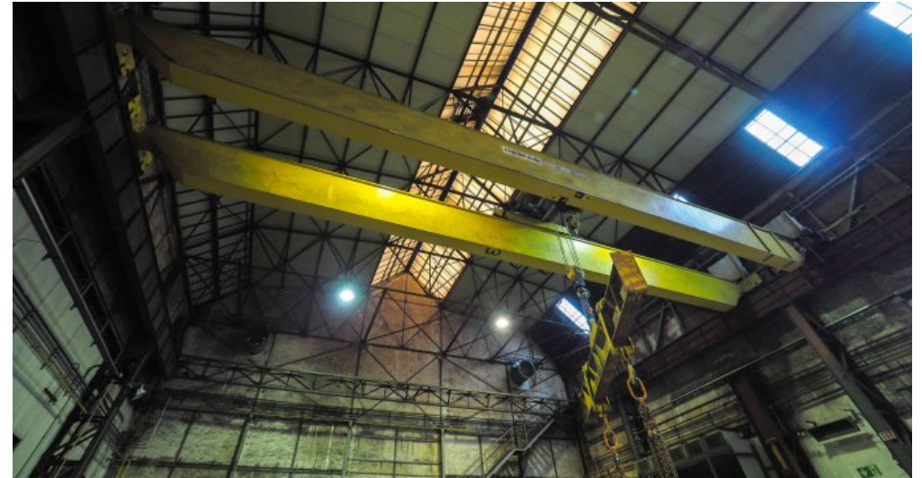
Industriehalle mit Kranbahn
