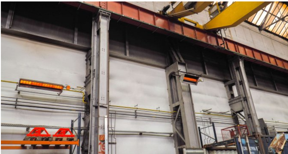
Industriehalle mit Kranbahn
