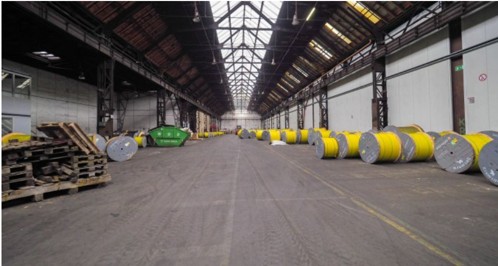
Industriehalle mit Kranbahn
