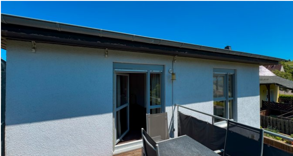
Ansicht Fassade von Balkon
