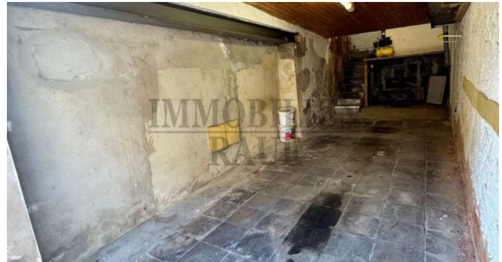
Garage (neben dem Haus)
