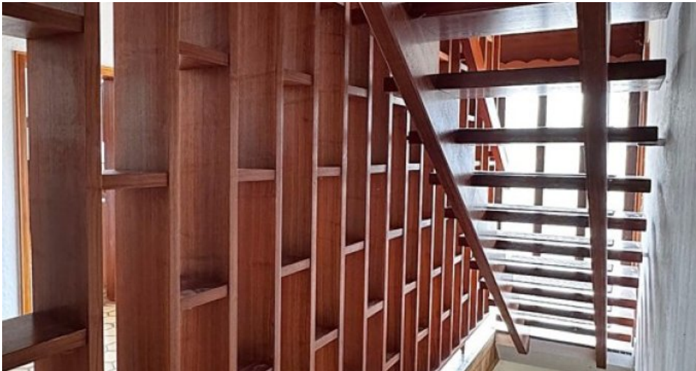
Treppe zum UG
