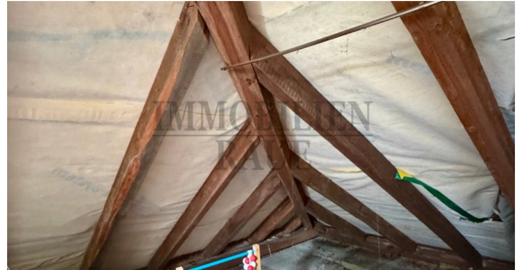
Abstellraum im DG
