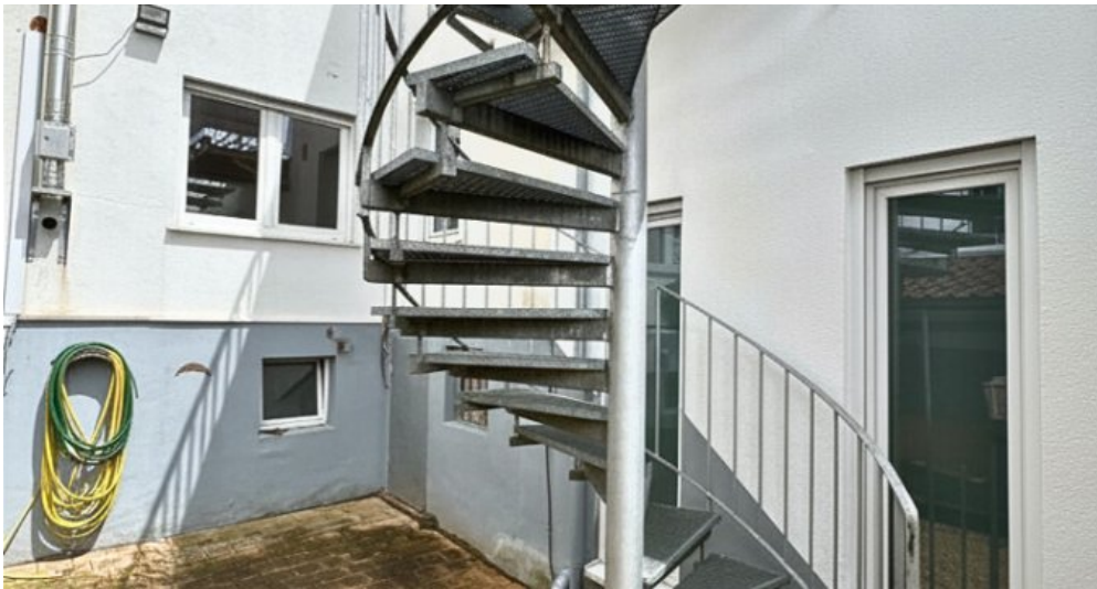
Wendeltreppe zur OG-WHG
