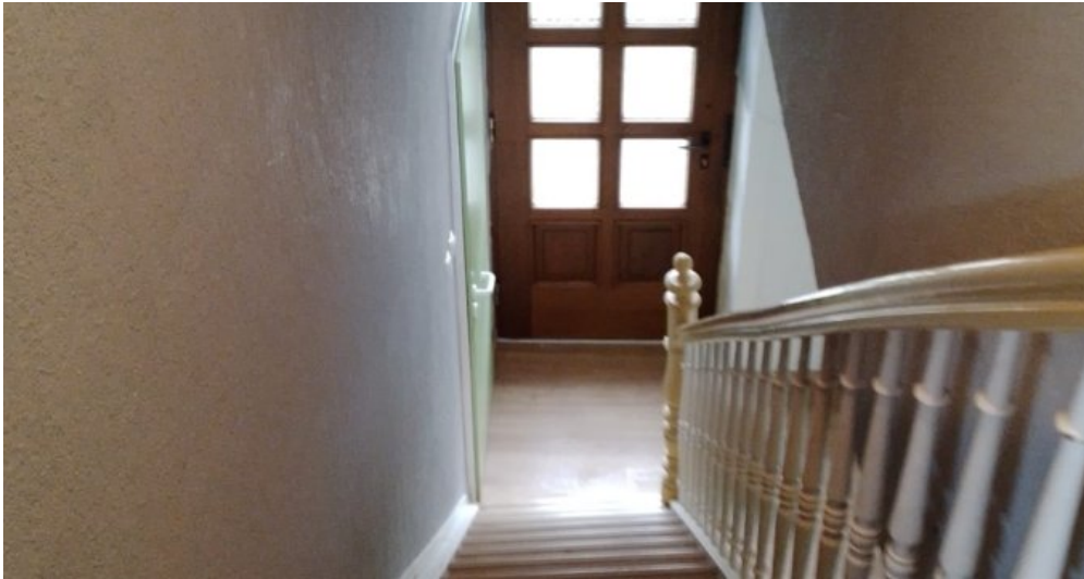
Treppe zum Dachgeschoss
