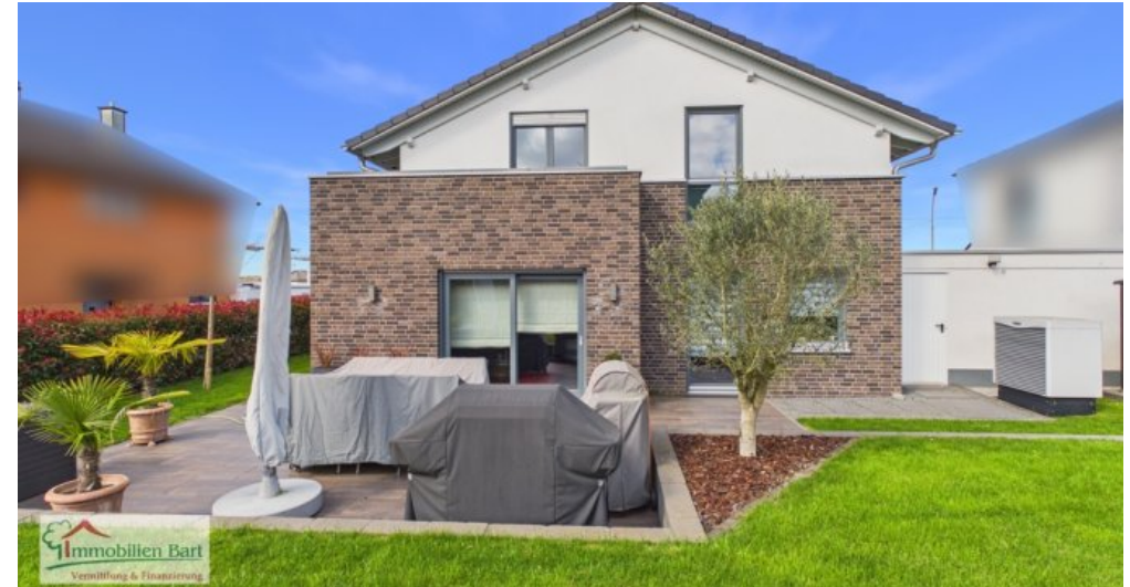
Rasen- und Terrassenfläche
