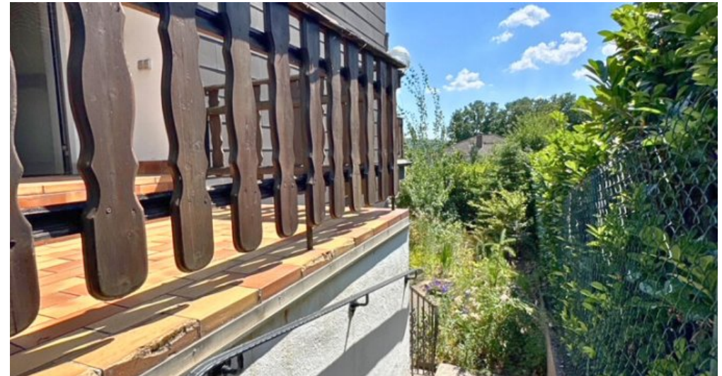
Treppe zum EG
