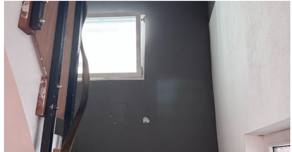
Wohnung EG Treppenaufgang
