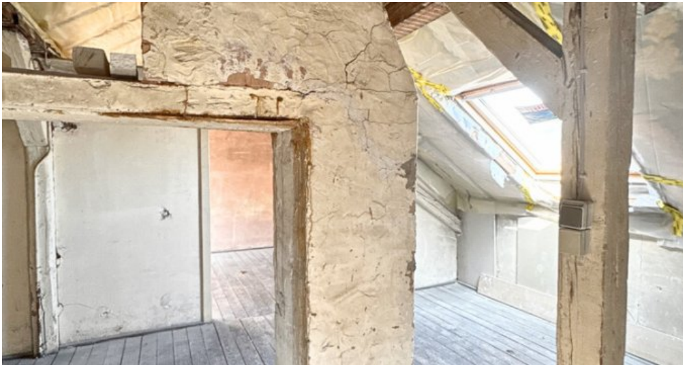
Ausbaufäche im DG
