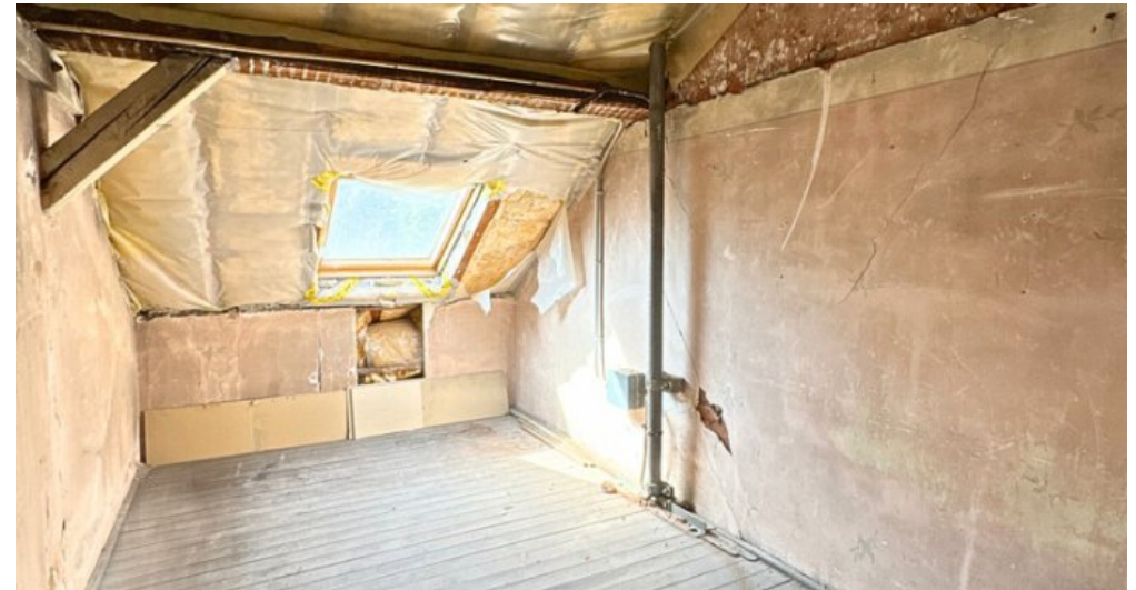
Raum im DG
