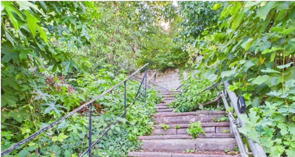
Treppe zum Haus
