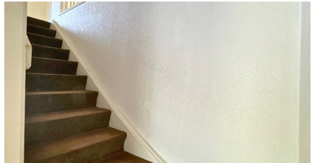
Treppe zum OG
