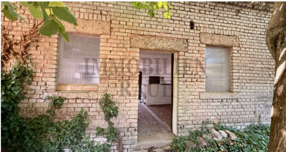
Zugang zur Scheune vom Garten
