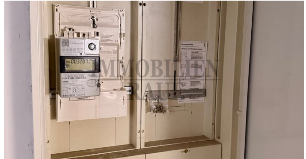
Stromzählerschrank
