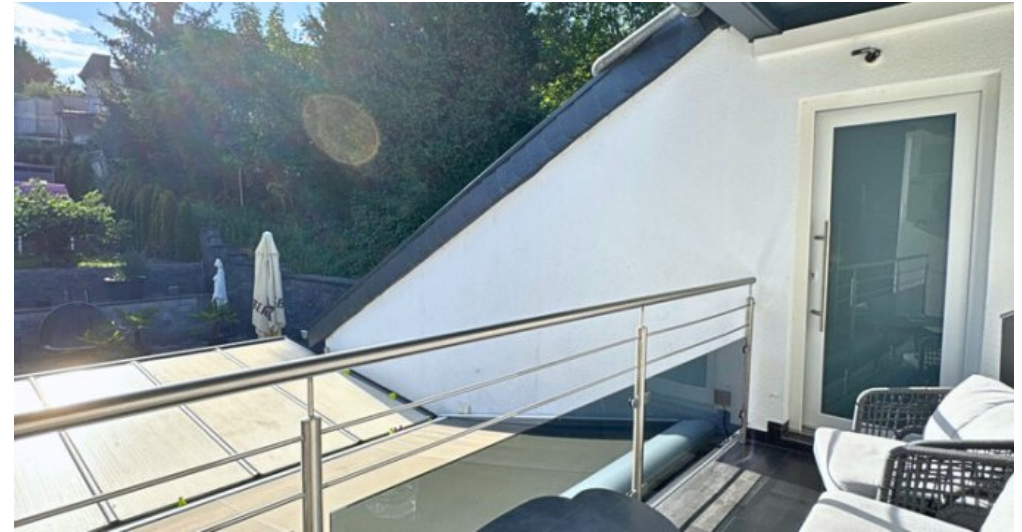
Überdachter Balkon DG
