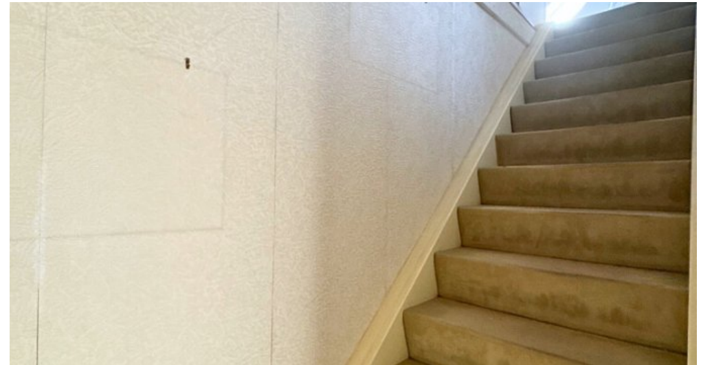
Treppe zum DG
