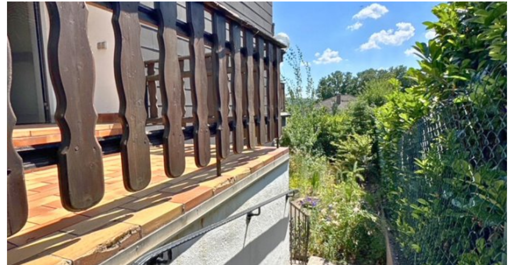
Treppe zum EG
