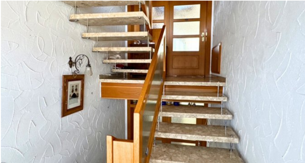
Treppe zum OG
