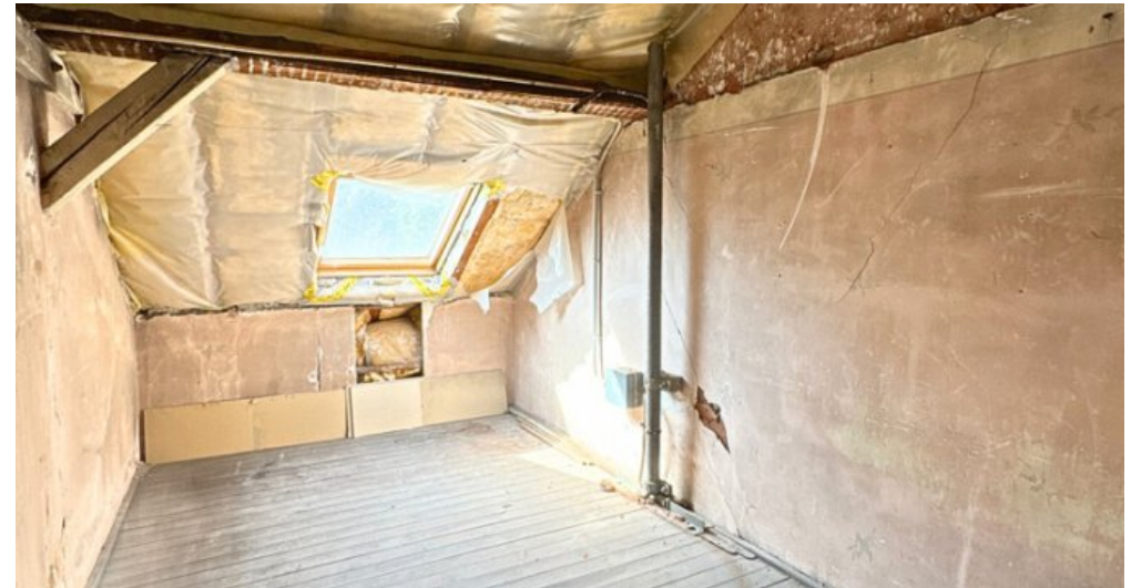
Raum im DG
