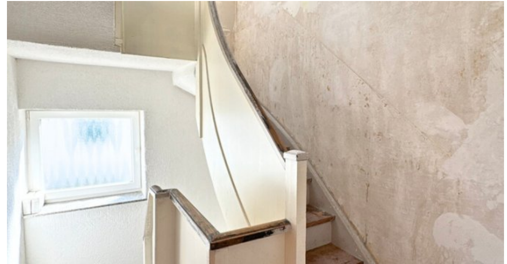
Treppe zum DG
