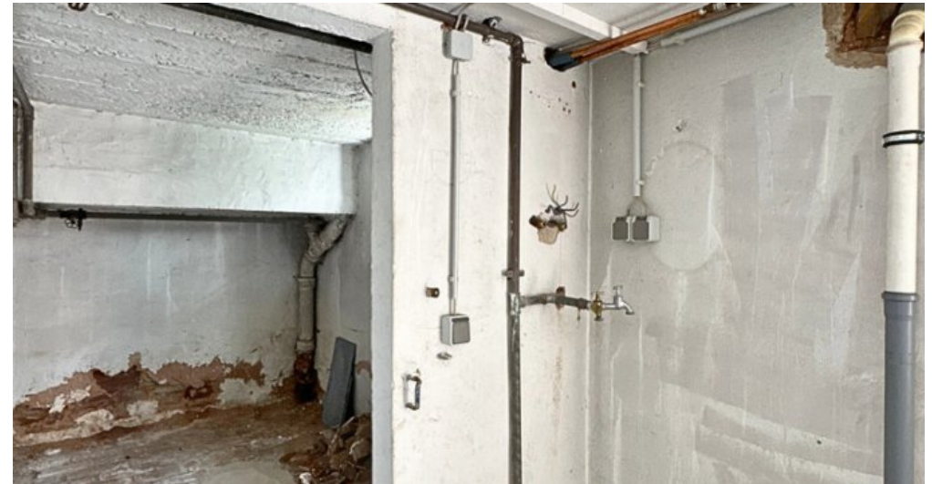
Waschmaschinenanschluss KG
