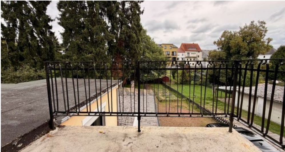
Balkon im OG
