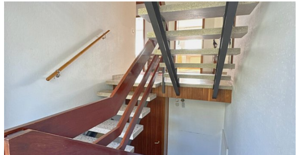
Treppe zum UG
