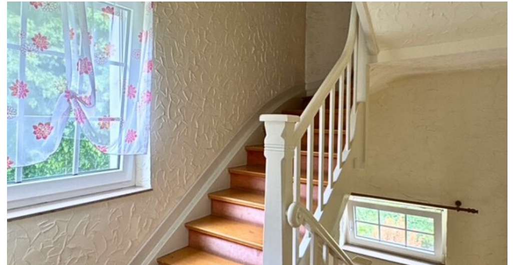
Treppe zum DG
