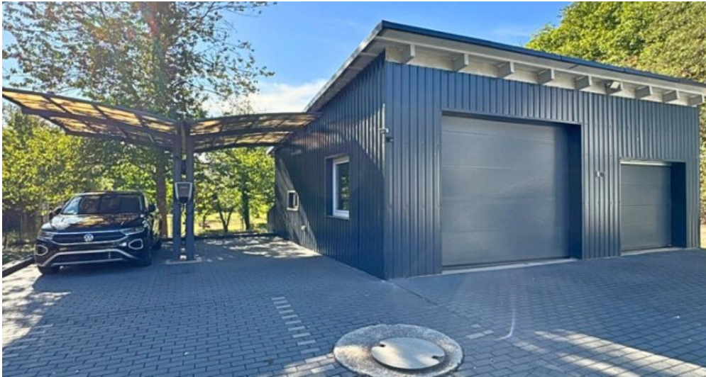
Garagen und Carport mit Wallbox
