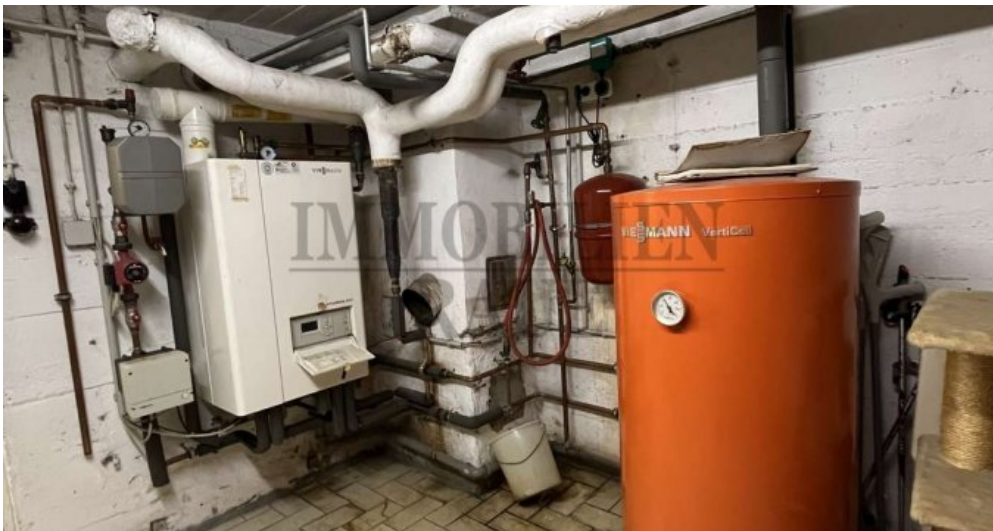
Gas-Zentralheizung (Brennwertgerät)
