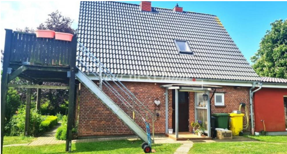
Hintereingang und Treppe zum OG
