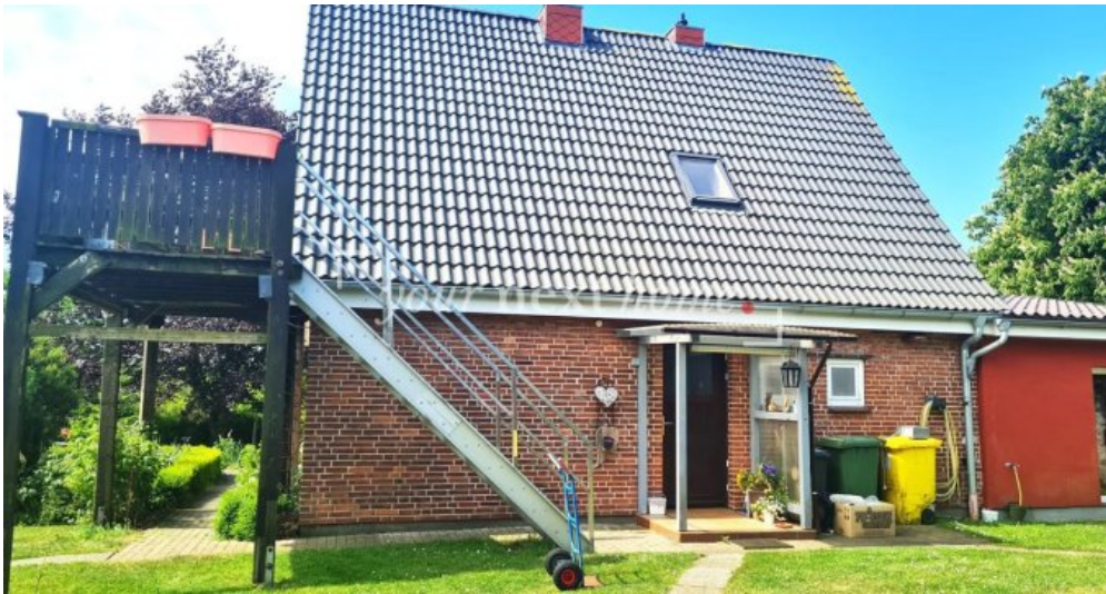
Hintereingang und Treppe zum OG
