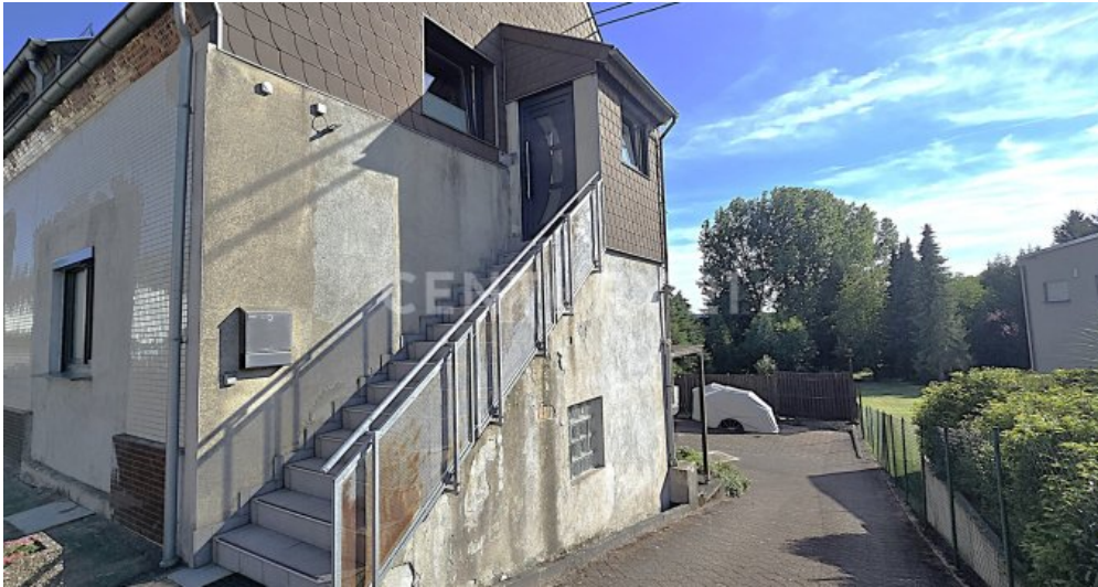
Seitlicher Eingang zur Wohnung 3 und Einfahrt
