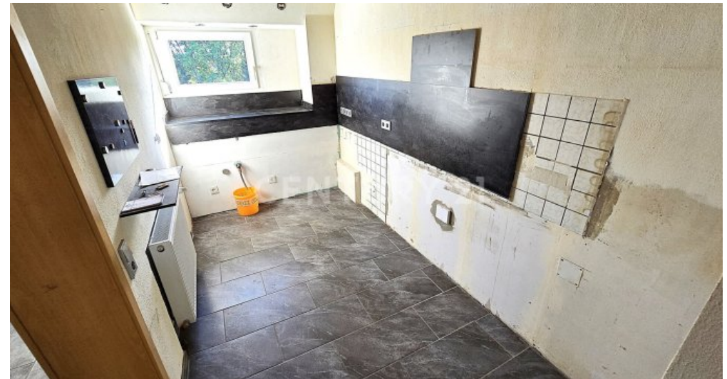
Küche der Wohnung im Obergeschoss
