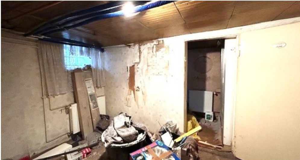
Baustelle Bad EG
