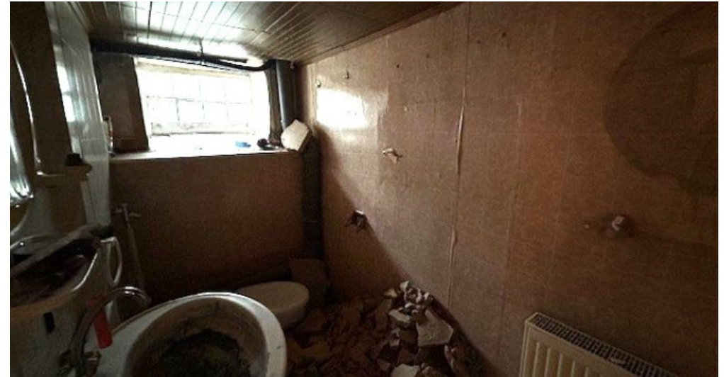
Baustelle Bad EG..
