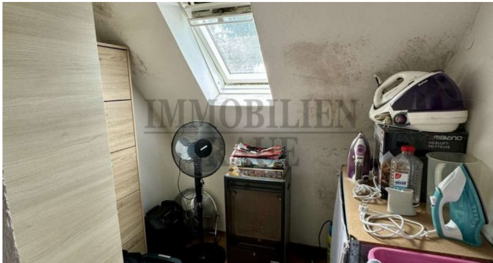
Abstellraum im DG
