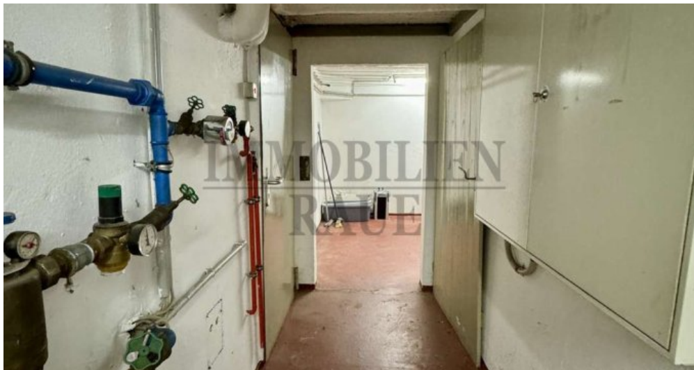
Flur im Keller
