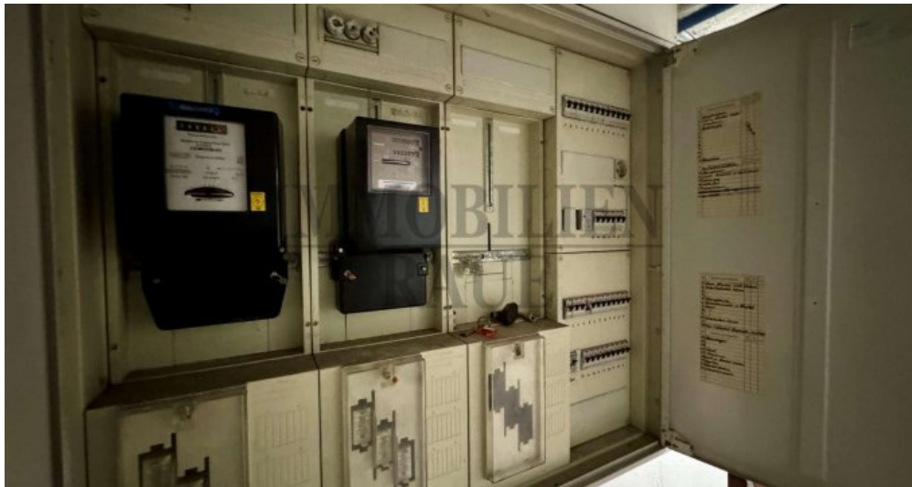
Stromzählerschrank
