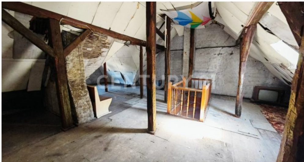
Viel Platz unter dem Dach
