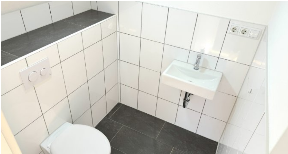
WC im DG
