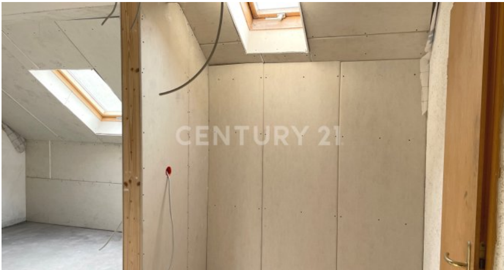
Blick in die DG Wohnung vom Flur
