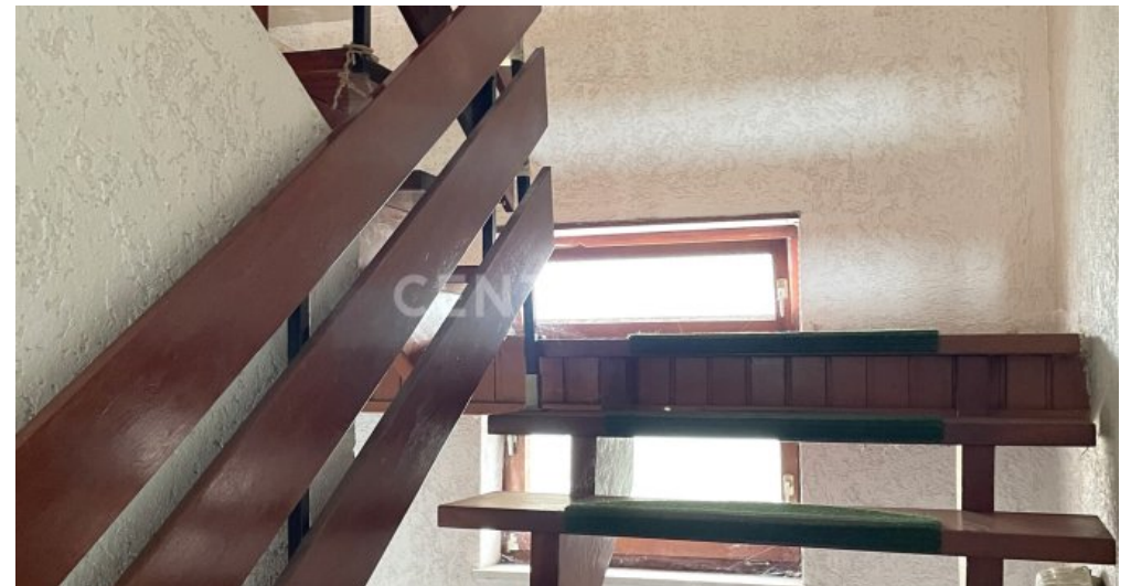
Treppe zum DG
