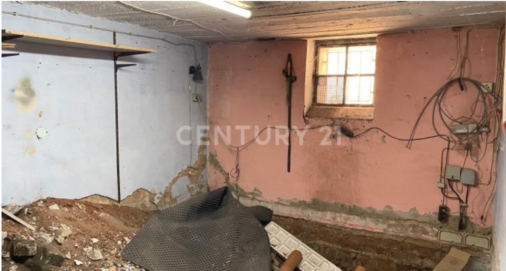
Kellerloch - Gleicher Raum
