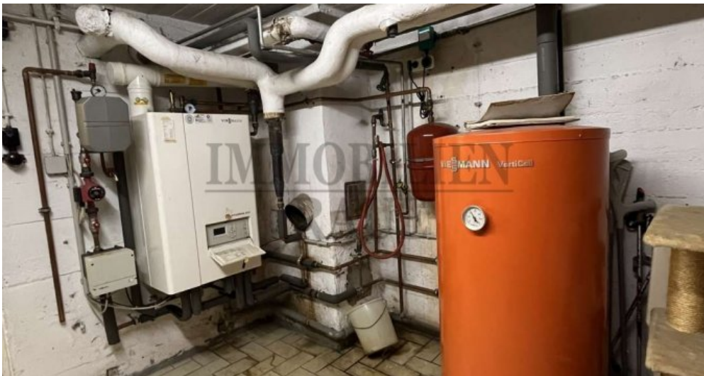
Gas-Zentralheizung (Brennwertgerät)
