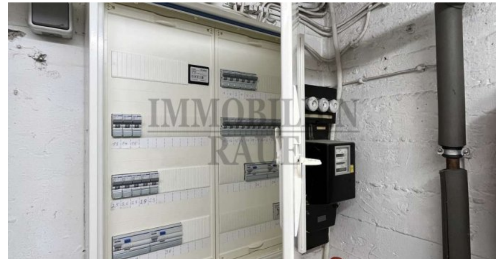
Stromzählerschrank
