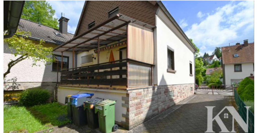
Einfahrt und Balkon Anbau
