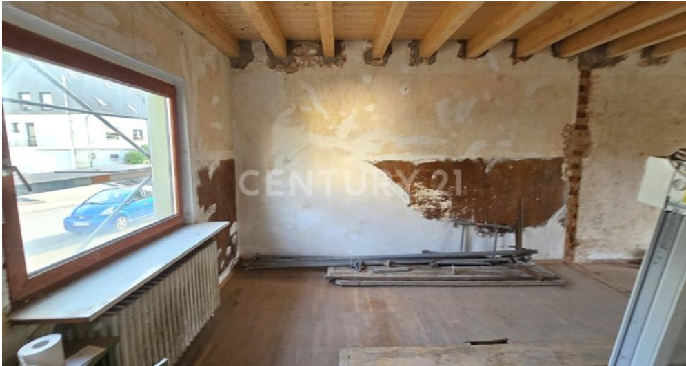
Eingangsbereich der Küche aktuell
