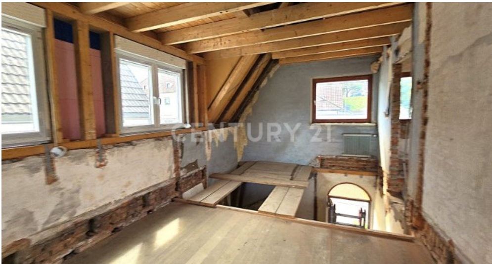
Treppenhaus im OG und mögl. Fläche für Badezimmer
