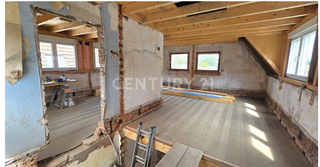
Treppenhaus im OG mit Zugang zum Kinderzimmer und mögl. Bad
