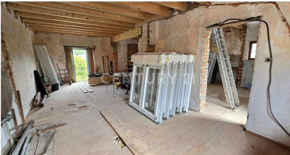
Aktueller Blick von der Küche zum Esszimmer
