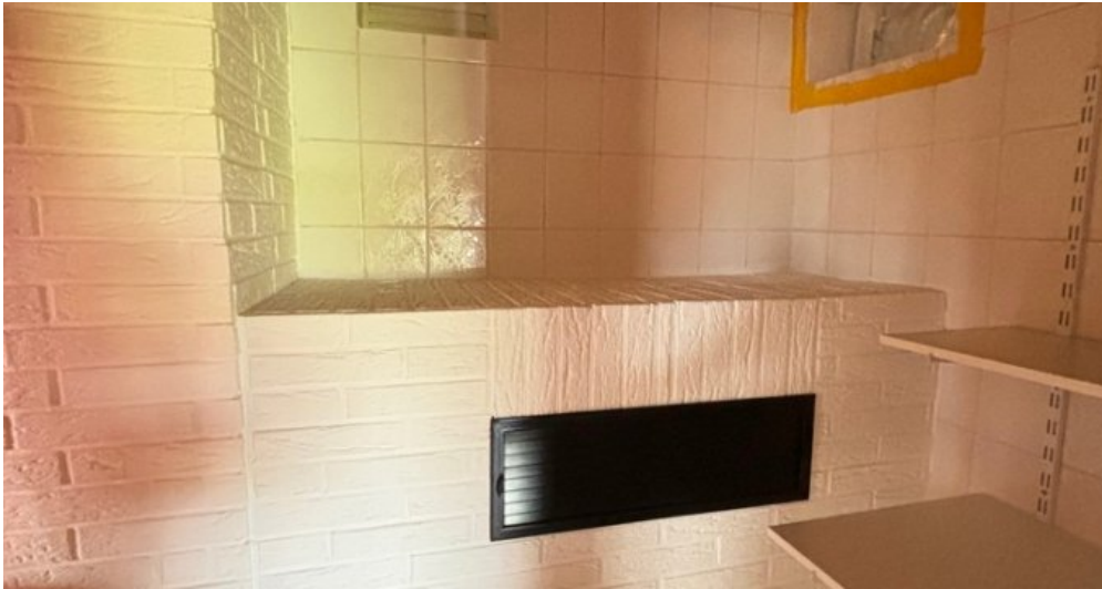
Vorratsraum mit Kaminschacht
