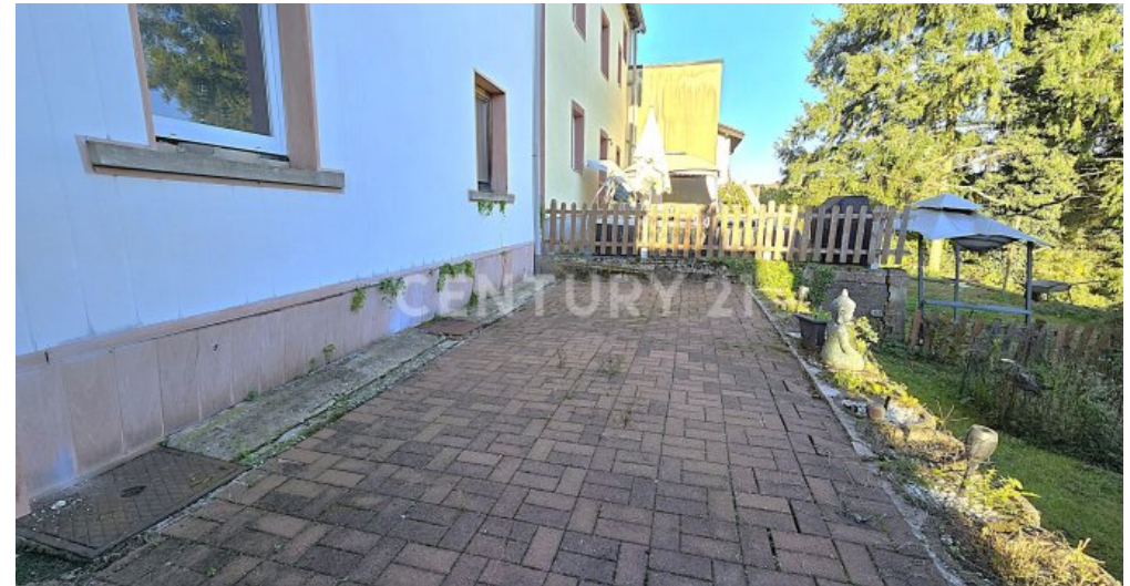
Ca. 20m 2 große Terrasse hinter dem Haus
