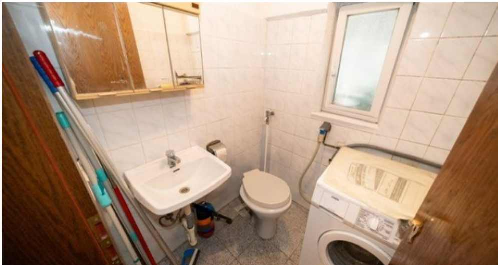
WC der Hauptwohnung im 1. OG
