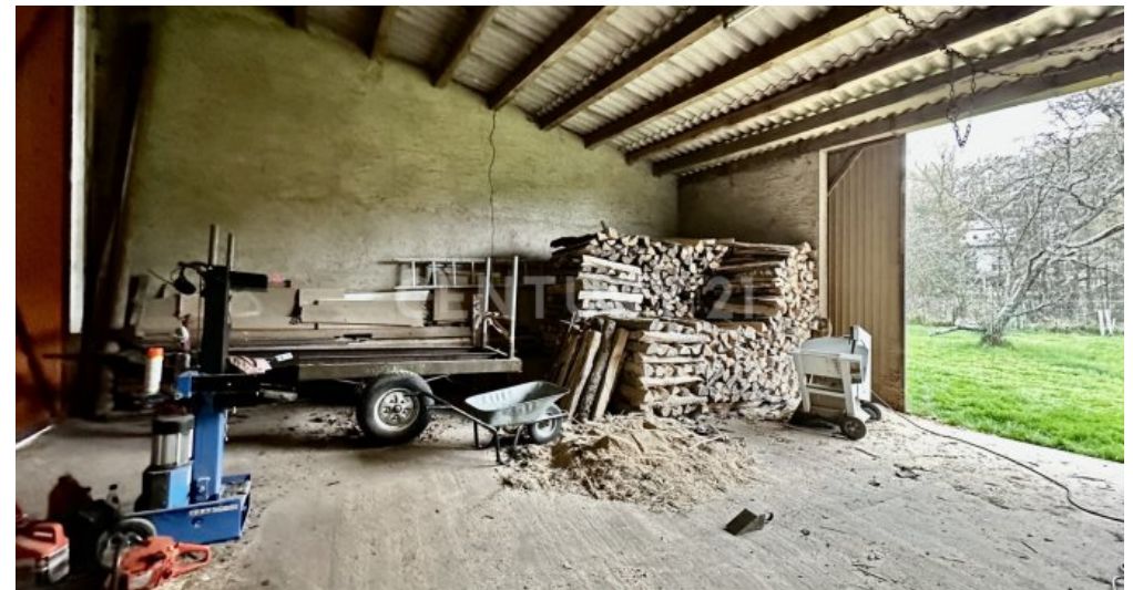
Scheune - Ansicht Zugang Garten
