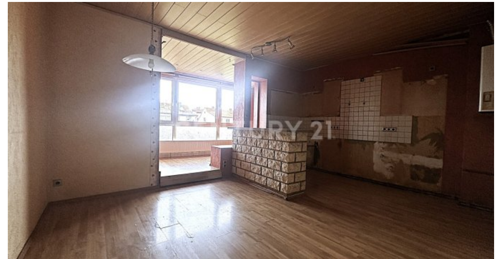
Küche im Dachgeschoss in Richtung Anbau
