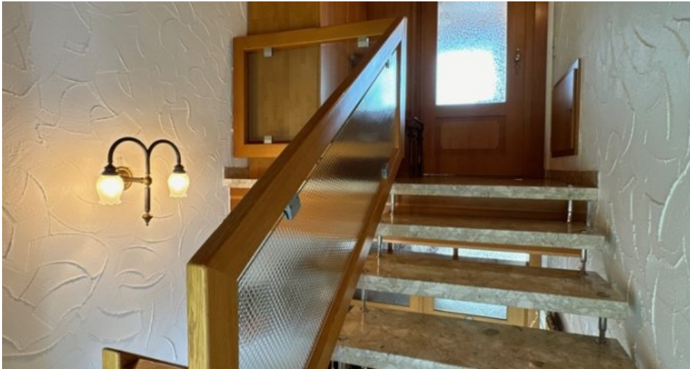
Treppe zum DG
