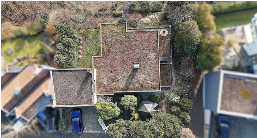
Luftbild des Grundstücks
