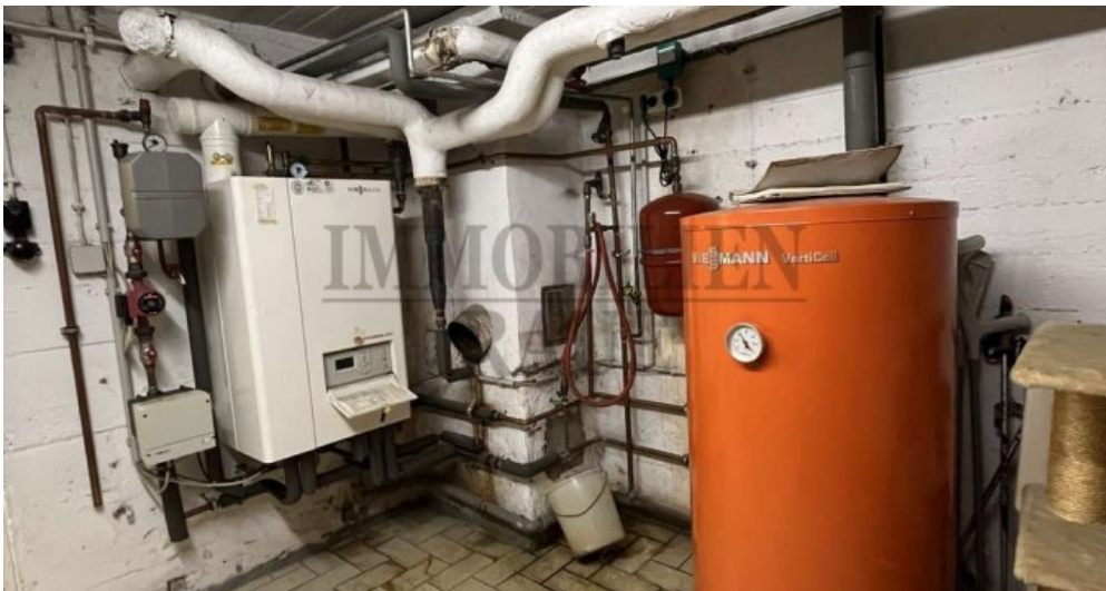
Gas-Zentralheizung (Brennwertgerät)
