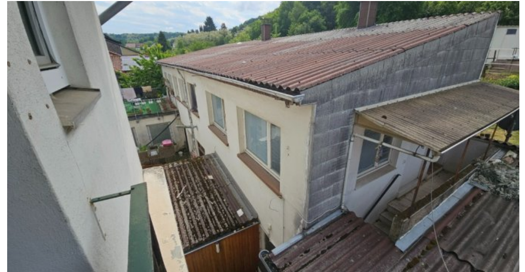
Blick auf das Hinterhaus
